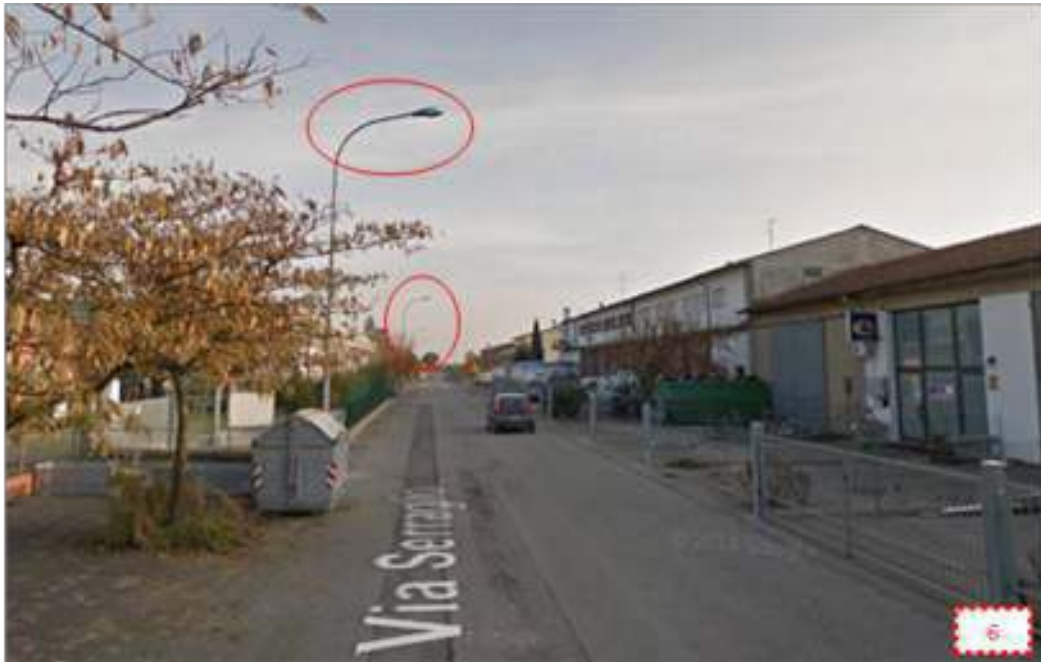
Figura 37. Esempi di illuminazione non conforme nella zona produttiva di Castel Bolognese. Fonte: Google Earth.
