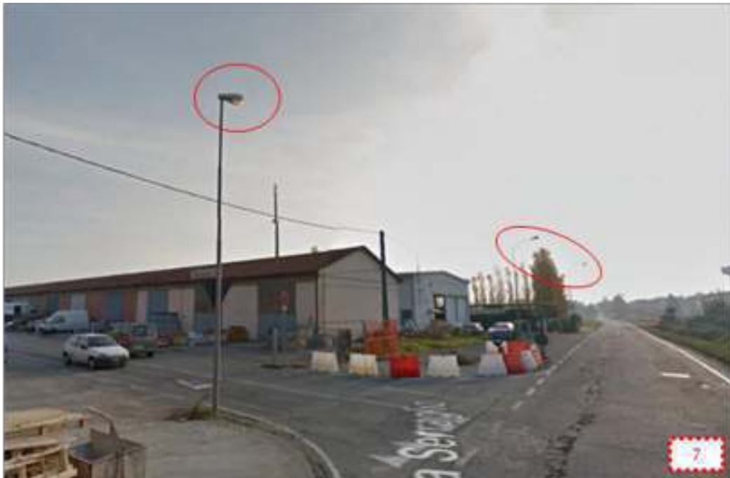
Figura 38. Esempi di illuminazione non conforme nella zona produttiva di Castel Bolognese. Fonte: Google Earth.
