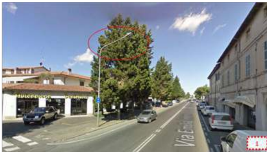
Figura 32. Esempio di illuminazione pubblica non conforme nel centro abitato di Castel Bolognese. Fonte: Google Earth.
