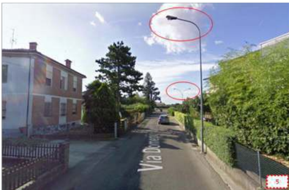
Figura 36. Esempi di illuminazione non conforme nella zona produttiva di Castel Bolognese. Fonte: Google Earth.
