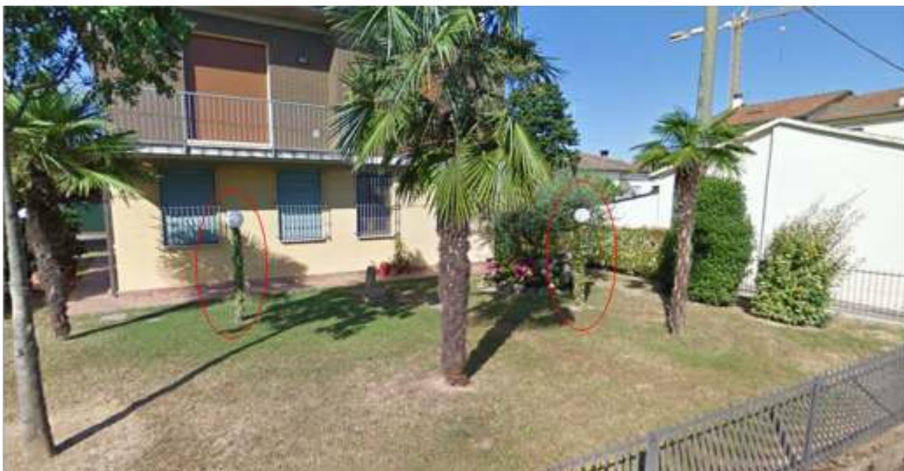
Figura 57. Esempio di illuminazione privata non conforme nell'area residenziale di Castel Bolognese. Fonte: Google Earth.
