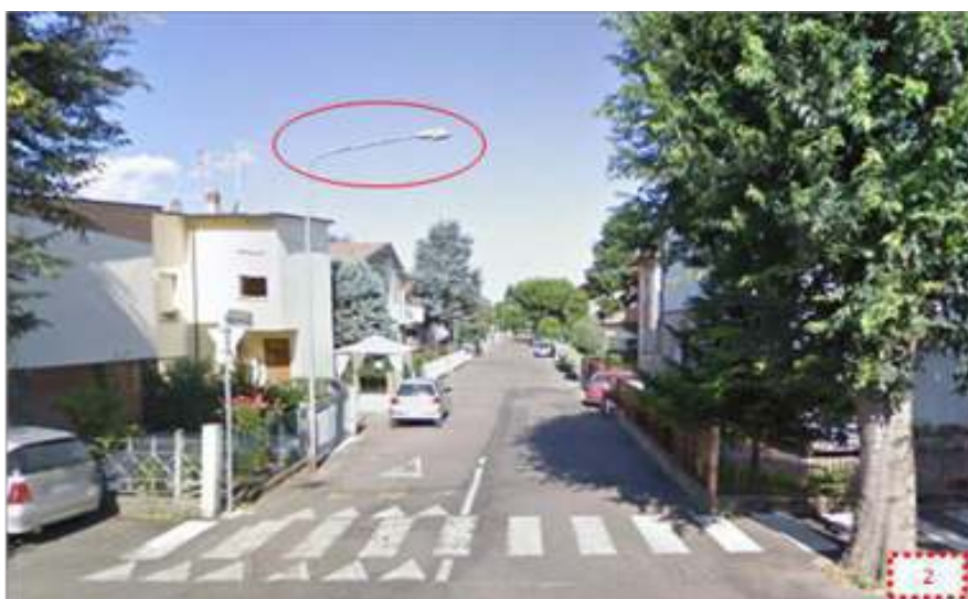
Figura 33. Esempio di illuminazione pubblica non conforme nel centro abitato di Castel Bolognese. Fonte: Google Earth.
