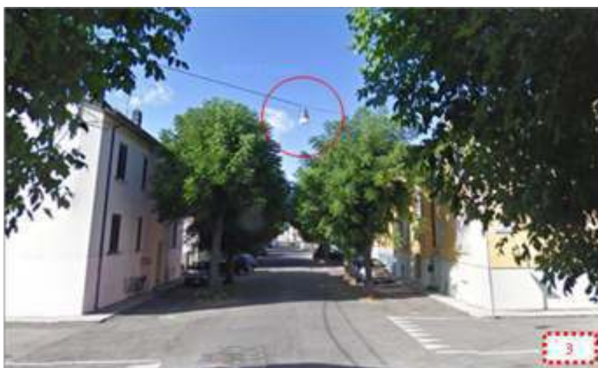
Figura 34. Esempio di illuminazione pubblica non conforme nel centro abitato di Castel Bolognese. Fonte: Google Earth.
